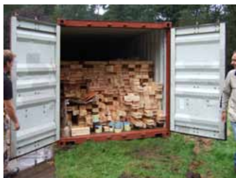
De aankomst van het kant en klare bouwpakket van de logs, voor het beheergebouw.
