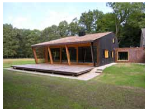
In totaal is er in het beheergebouw zo'n 75 m 3 hout toegepast van de eigen houtproductie uit de bossen van Landgoed Welna.
