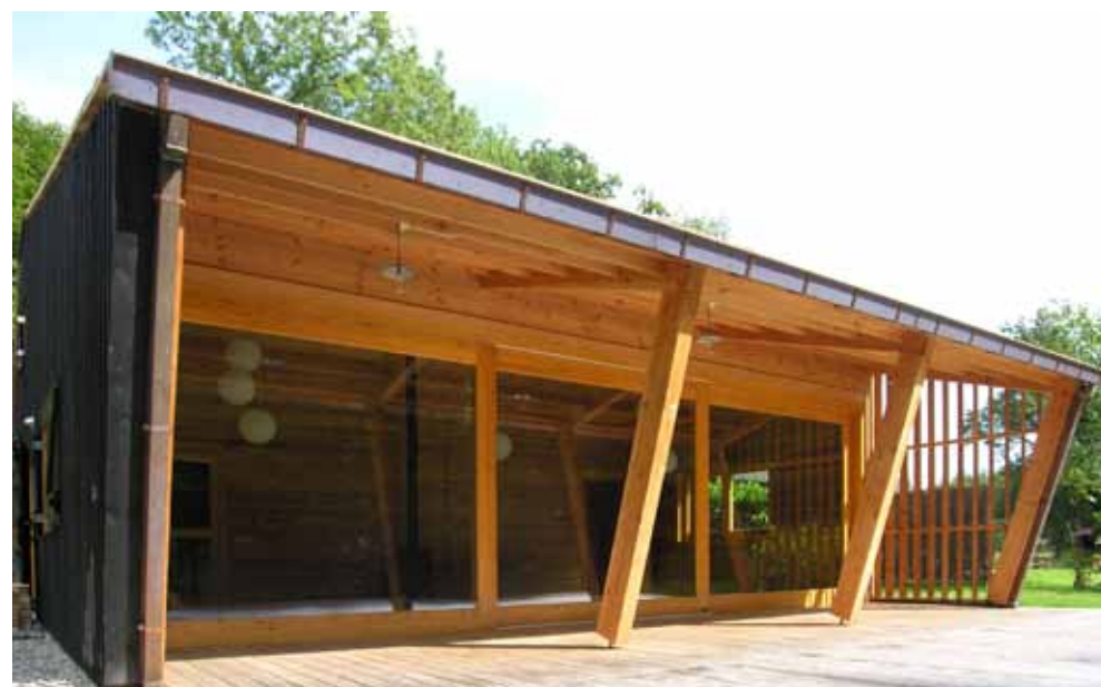
In totaal is er in het beheergebouw zo'n 75 m 3 hout toegepast van de eigen houtproductie uit de bossen van Landgoed Welna.
