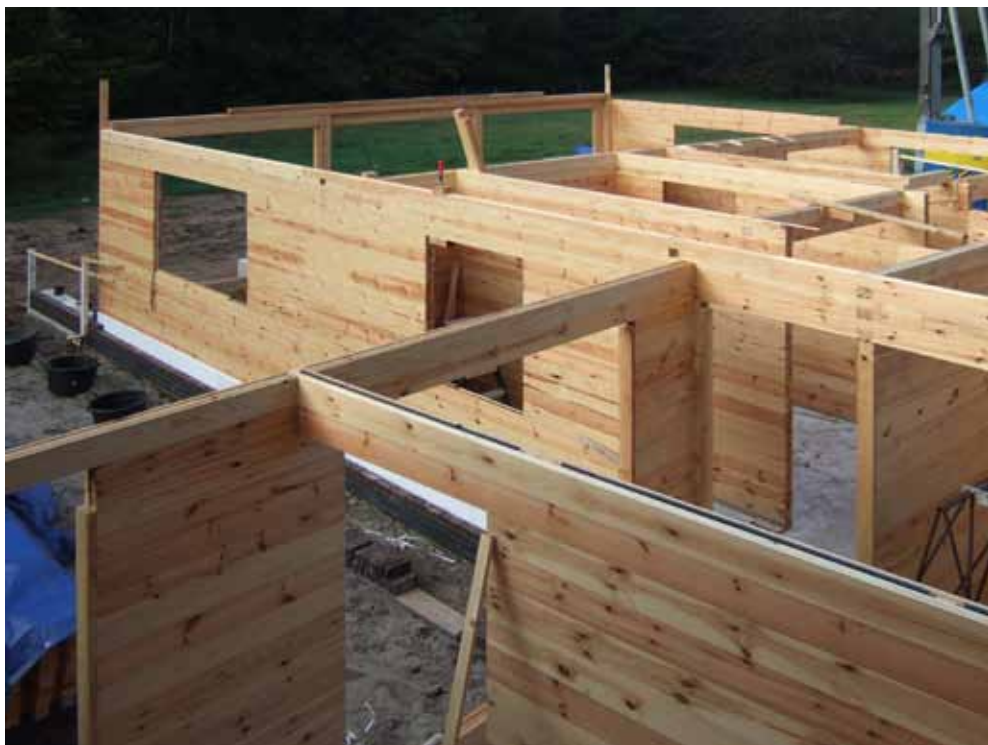
De logs hebben standaardafmetingen van 92 mm breed en 138 mm hoog. De langste logs meten circa 5 meter.
