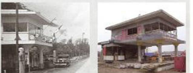
**2** Openlend aan het tankstation zijn de poldershoutenkolommen. Deze zijn, evenals het overige betonwerk, afgebikt en gerepareerd met reparatiemortel. Het tankstation is vaak volboswend. Zo waren de oorspronkelijk staal kozijnen op de benedenverdieping vervangen door houten punten. Dit is hersteld. Ook veel van het originele metaalwerk was verlaakt gegaan. Dit is opnieuw gemetseld met groen geglaasuurde bakstenen. Om de kleur precies goed te krijgen, zijn 23 monsters gemaakt.
